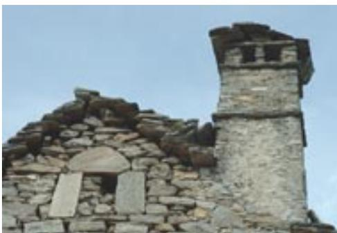
Questa torre mostra di essere stata ottenuta sopraelevando una parte del corpo di una precedente costruzione, della quale non fu neppure tolto il tetto in pesanti piode che è rimasto, come è visibile dalla fotografia, inserito circa a metà della costruzione.
