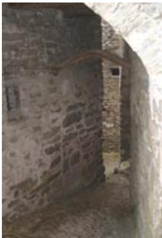
Alcune di esse, visibili soprattutto sul lato Sud, superano i m. 1,50 di lunghezza e raggiungono talvolta i m. 1,95. Ma verso il centro del muro appaiono anche pietre di minori dimensioni e frammenti. Le pietre sono poste tutte di taglio in corsi non regolari e solo grossolanamente paralleli. Lo strato di malta che tiene insieme le pietre è piuttosto spesso, da 1 a 3 cm; all'interno il muro è praticamente a sacco, cioè di frammenti di pietra cementati da abbondante e durissima malta.
